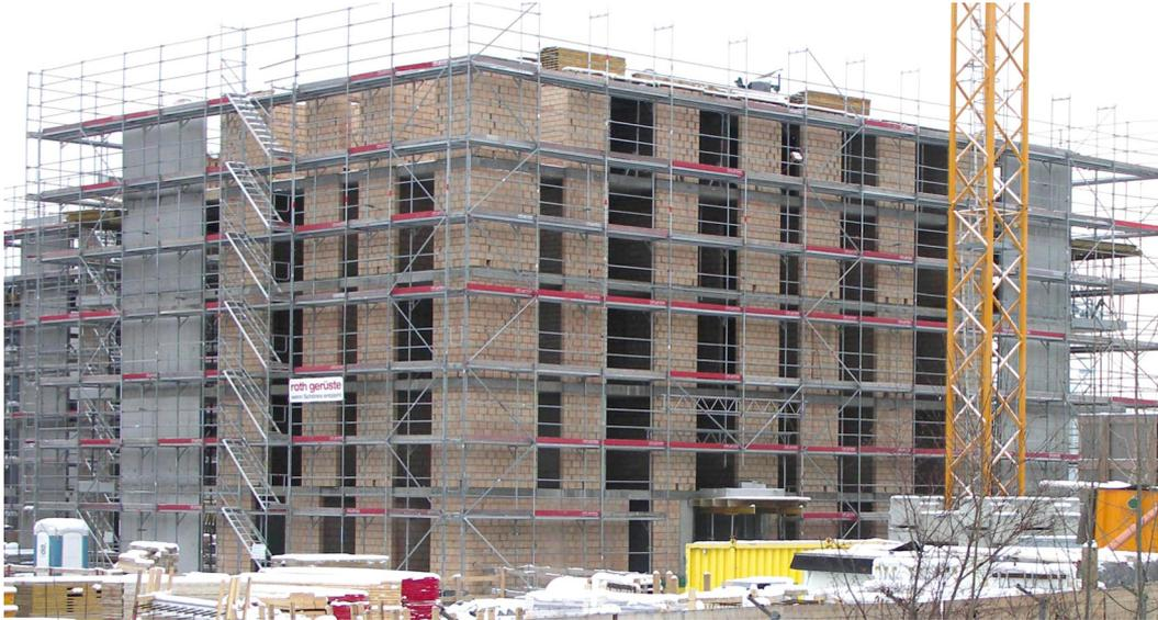
Abbildung 2: Bei mehrgeschossigen, unbewehrten Mauerwerksgebäuden werden in der Regel zwei Stahlbetontragwände pro Hauptrichtung im Grundriss zur Aufnahme der Erdbebenbeanspruchung erforderlich,
