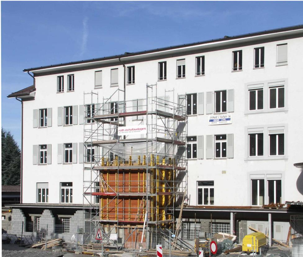
Abbildung 5: Schulgebäude in Monthey wird mit neuem aussenliegendem Liftkern aus Stahlbeton erdbebenertüchtigt.
